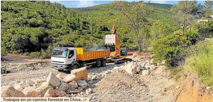
Trabajos en un camino forestal en Chiva. LP
