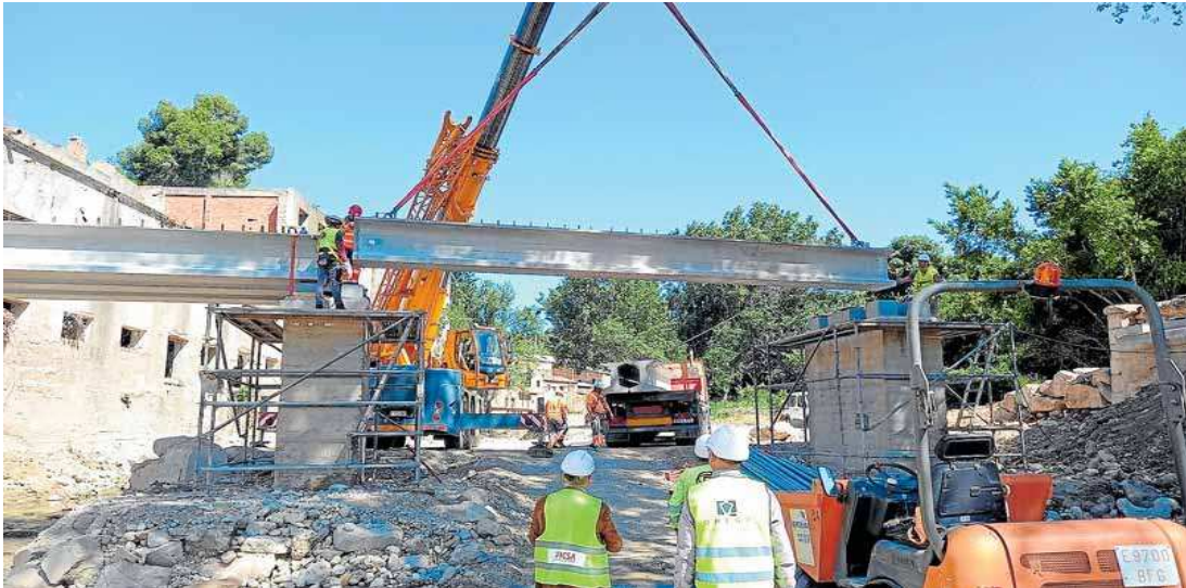
Trabajos de instalación de nuevas vigas en la reparación de uno de los puentes dañados por la dana en el término de Buñol. LP
